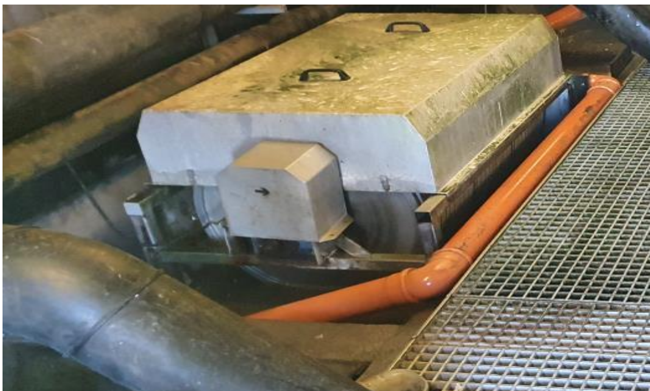
Mynd 9. Tromlufilter. Seyran rennur eftir röri í seyruþró.
