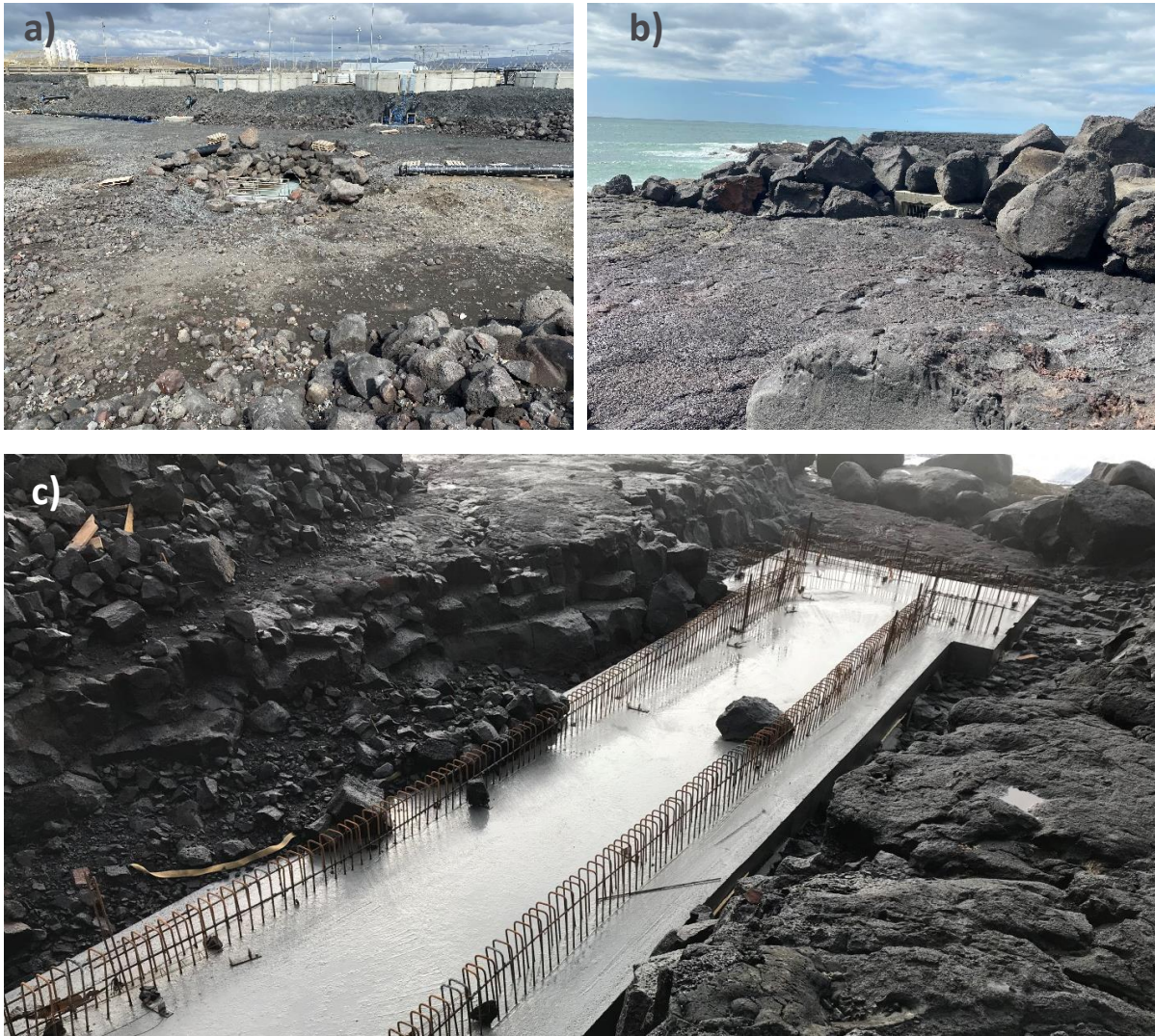
MYND 3-3 Eystri fráveita frá eldisstöð Íspórs. Fráveitan er niðurgrafin nema við fiskigildru (mynd a) og útrás í viðtaka (mynd b). Frá fiskigildru og að útrás í sjó liggur fráveitan í steypum stokk, svokölluðum hamarshaus. Á mynd c) má sjá grunninn sem hamarshausinn var steypur á. Hann er nú hulin jarðvegi og stórgrýti (sjá mynd a og b).
