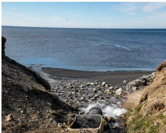
Mynd 2.4. Frárennslið hjá Fiskeldinu Haukamýri fellur framan af bakka niður í sandfjöru. Útbúnir hafa verið varnargarðar úr grjóti til að verja bakkana sem eru að hluta til farnir vegna mikils álags af haföldu.
