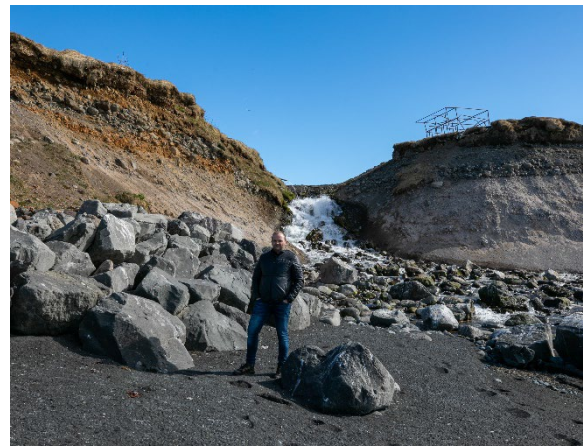
Mynd 2.4. Frárennslið hjá Fiskeldinu Haukamýri fellur framan af bakka niður í sandfjöru. Útbúnir hafa verið varnargarðar úr grjóti til að verja bakkana sem eru að hluta til farnir vegna mikils álags af haföldu.
