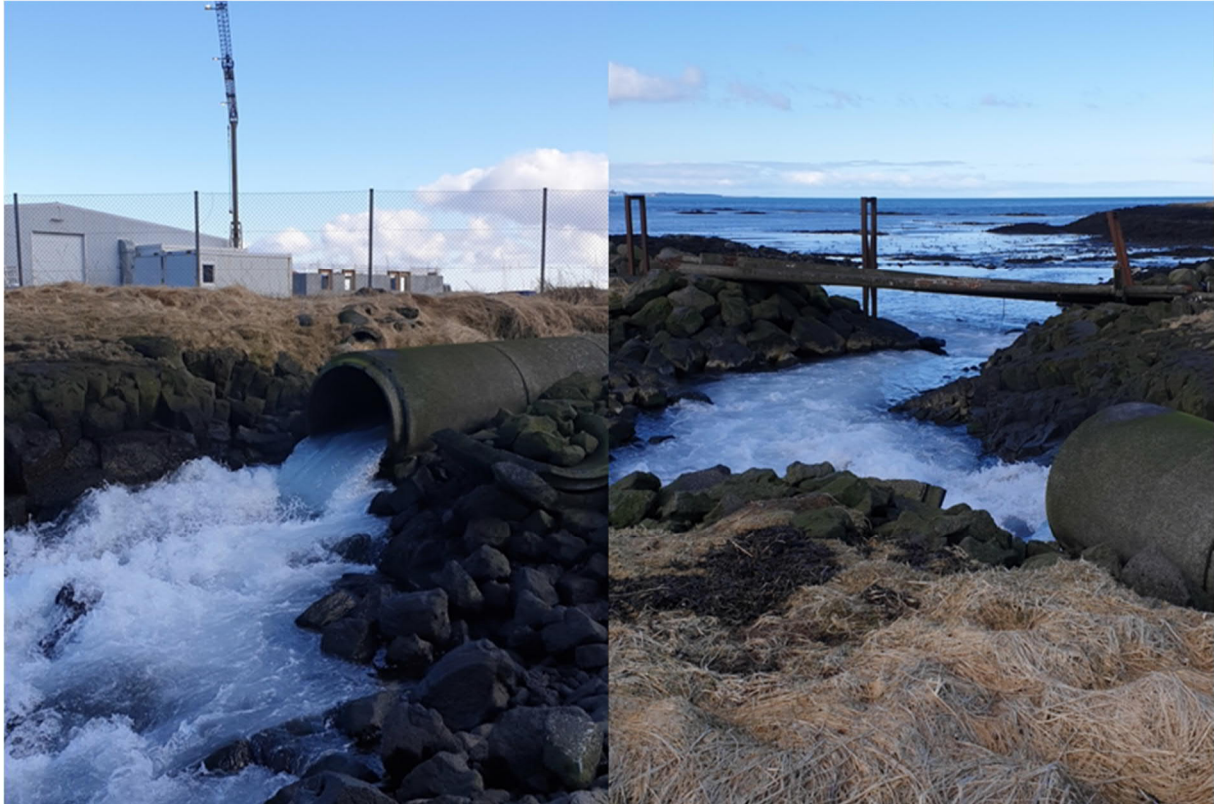
Mynd 3.11 Útrás frárennslis í Vogavíkurfjöru.
