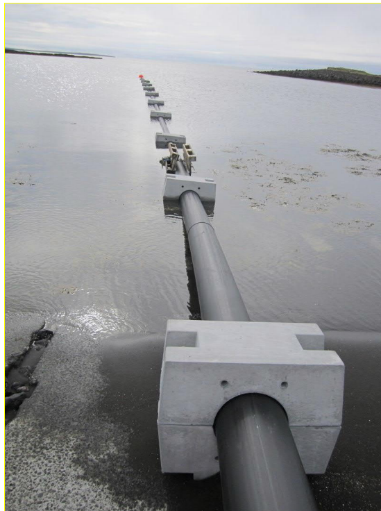
Mynd 4.5 Dæmi um forsteyptar sökkur sem notaðar eru til að sökkva fráveitulögn. 8
