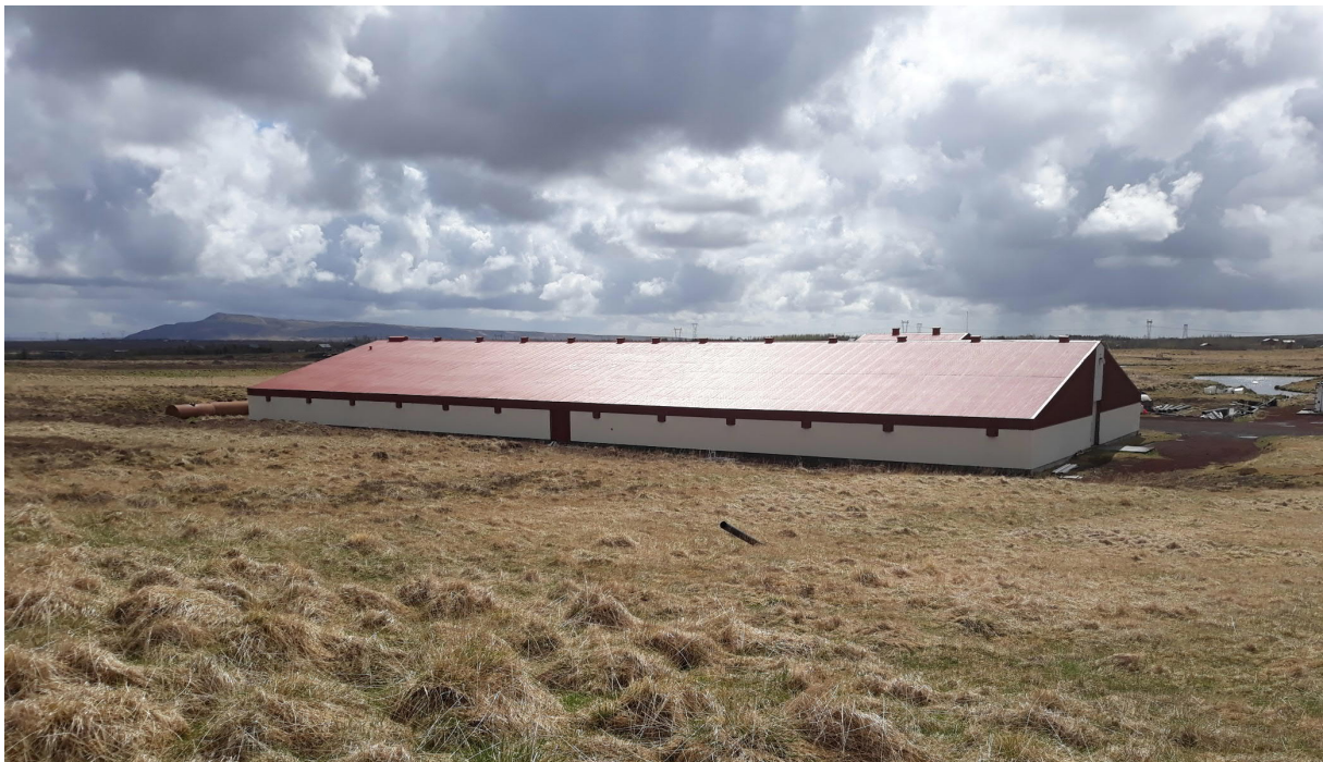
Mynd 3.1 Eldishús að Hallkelshólum, horft til suðurs.
