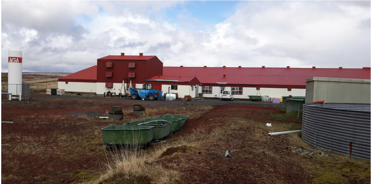
Mynd 2.1 Eldisstöðin að Hallkelshólum. Eldishús í bakgrunni með loftunarhús (dökkrautt) þar fyrir framan. Einnig sést í hluta eldiskera sem eru utandyra hægra megin á mynd og súrefniskút vinstra megin.
